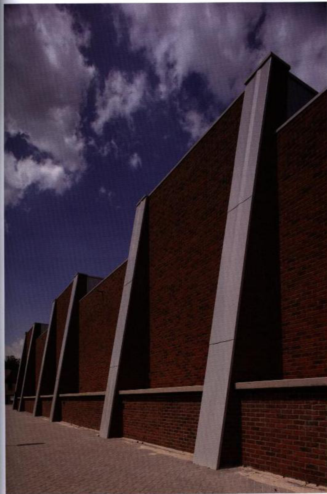
De steunberen van het 3000 m 2 Delhaize-pand werden ook in blauwe steen aangekleed.
