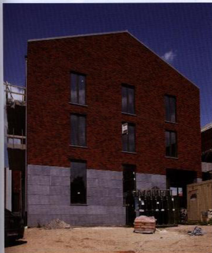
Het project kreeg overal een boord van 3 meter hoog in natuursteen. De gevelsteen werd op maat vervaardigd door Vandersanden.
